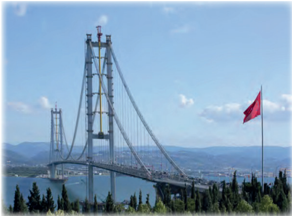
Görsel 3 Osmangazi Köprüsü
